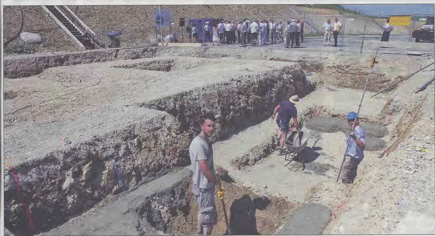
Während gestern Mittag im Hintergrund noch die Feier zum Baubeginn der Fernwärme-Übergabestation auf dem Geothermie-Kraftwerksgelände lief, wurden am künftigen Standort bereits die Vorarbeiten für die Fundamente erledigt. Fotos: hr
