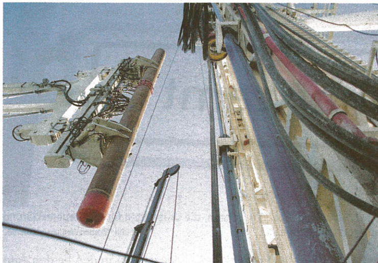
Die Bohrungen sind voll im Gange: Hier wird das nächste Rohr eingebaut, das zuerst verschraubt und dann in die Tiefe gedrückt wird. Bilder: js
