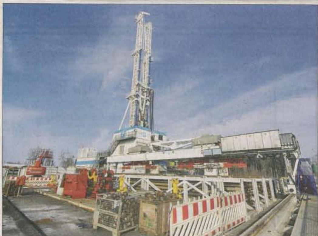
Seit Mitte Januar wird in Traunreut bereits nach heißem Wasser gebohrt, zum offiziellen Startschuss am gestrigen Dienstag waren die Meißel bereits bis in 1010 Meter Tiefe vorgedrungen.
