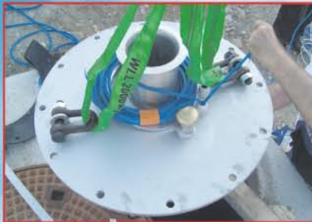
Einbau Brunnenpumpe mit Steigleitung.
